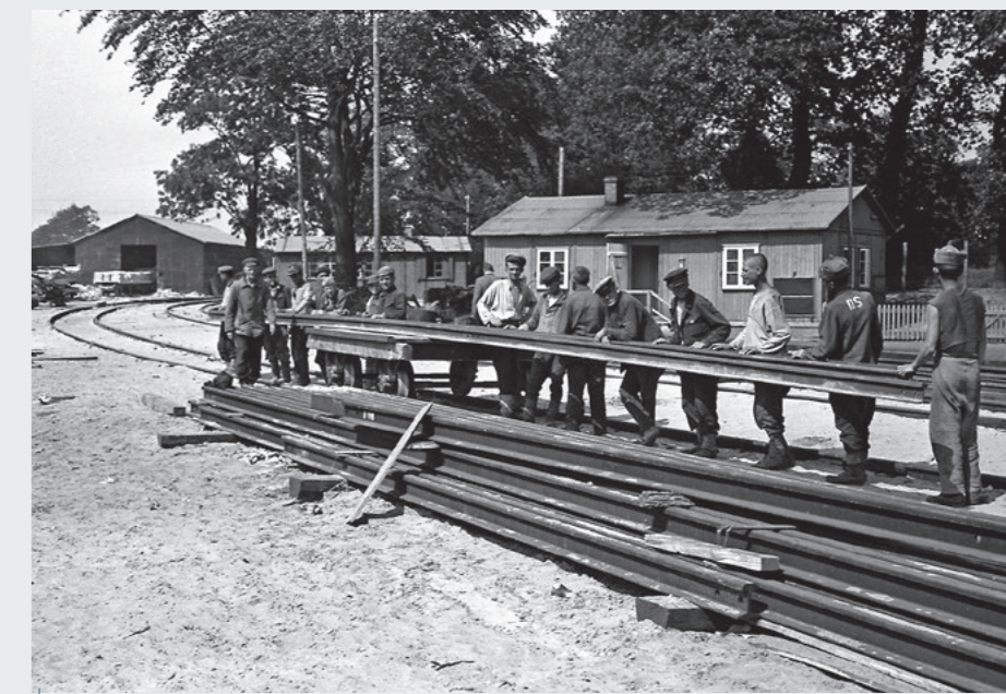
Sowjetische Kriegsgefangene beim Transport von Stahlträgern auf der Baustelle des Bunkers ›Valentin‹ Foto: Johann Seubert, © Landeszentrale für politische Bildung Bremen
